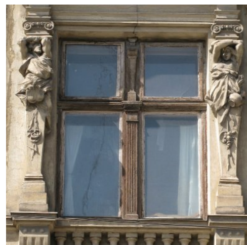
Рис. 6. Будинок по вул.Франка, 40
